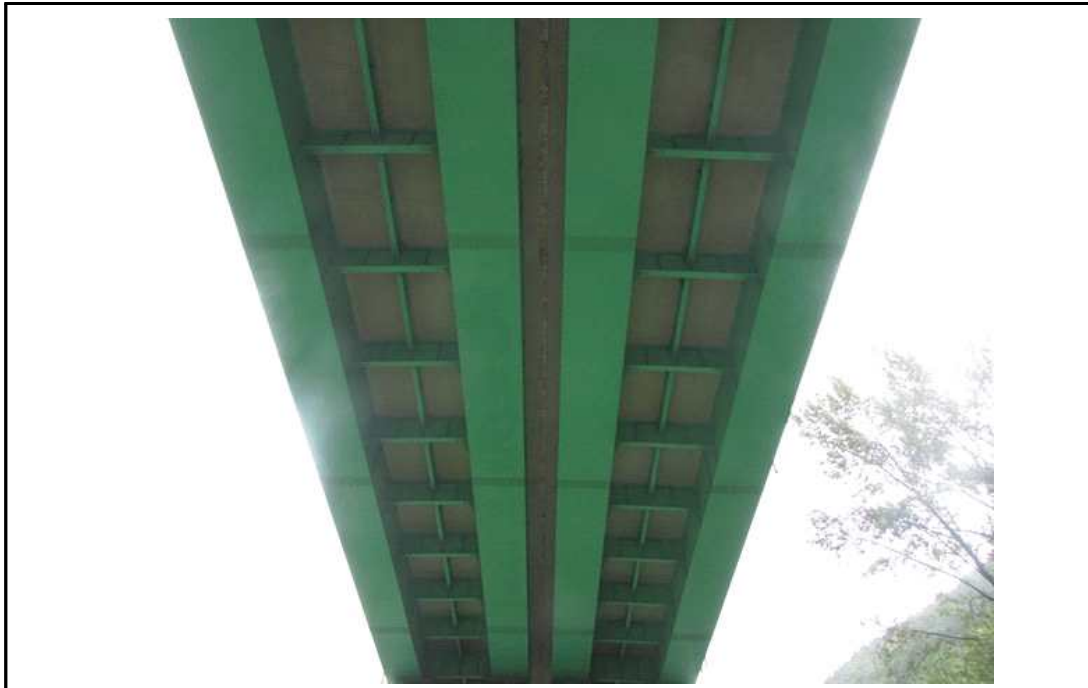
바닥판하면 및 강박스 외부전경
